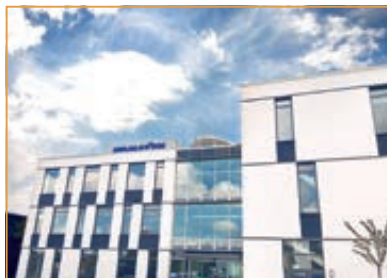
Das neue Technologiecenter in Benrath.
