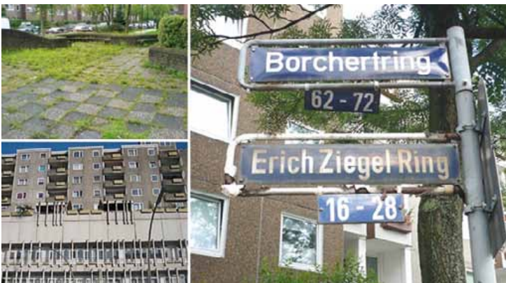
Planungsanlass: ... ungepflegtes Erscheinungsbild ... Image ... mangelnde Orientierung
