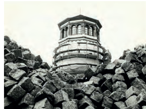
Neugestaltung von Schlossturm und Burgplatz, um 1983
