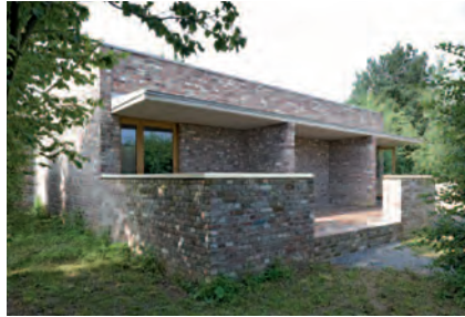
Räume für Fotografie, Raketenstation Hombroich (Architektur: Álvaro Siza mit Rudolf Finsterwalder)
