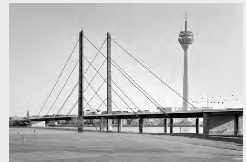
Tomas Riehle, Rheinbrücke , Düsseldorf
