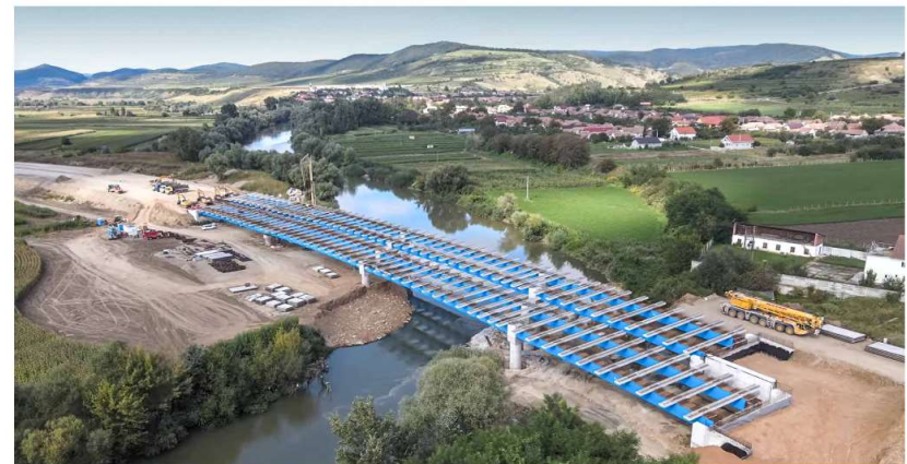
A10 SEBES – TURDA LOS 2, KM 40 + 200, MURESVIADUKT Stützenstellungen individuell angepasst an Querungsbereich
