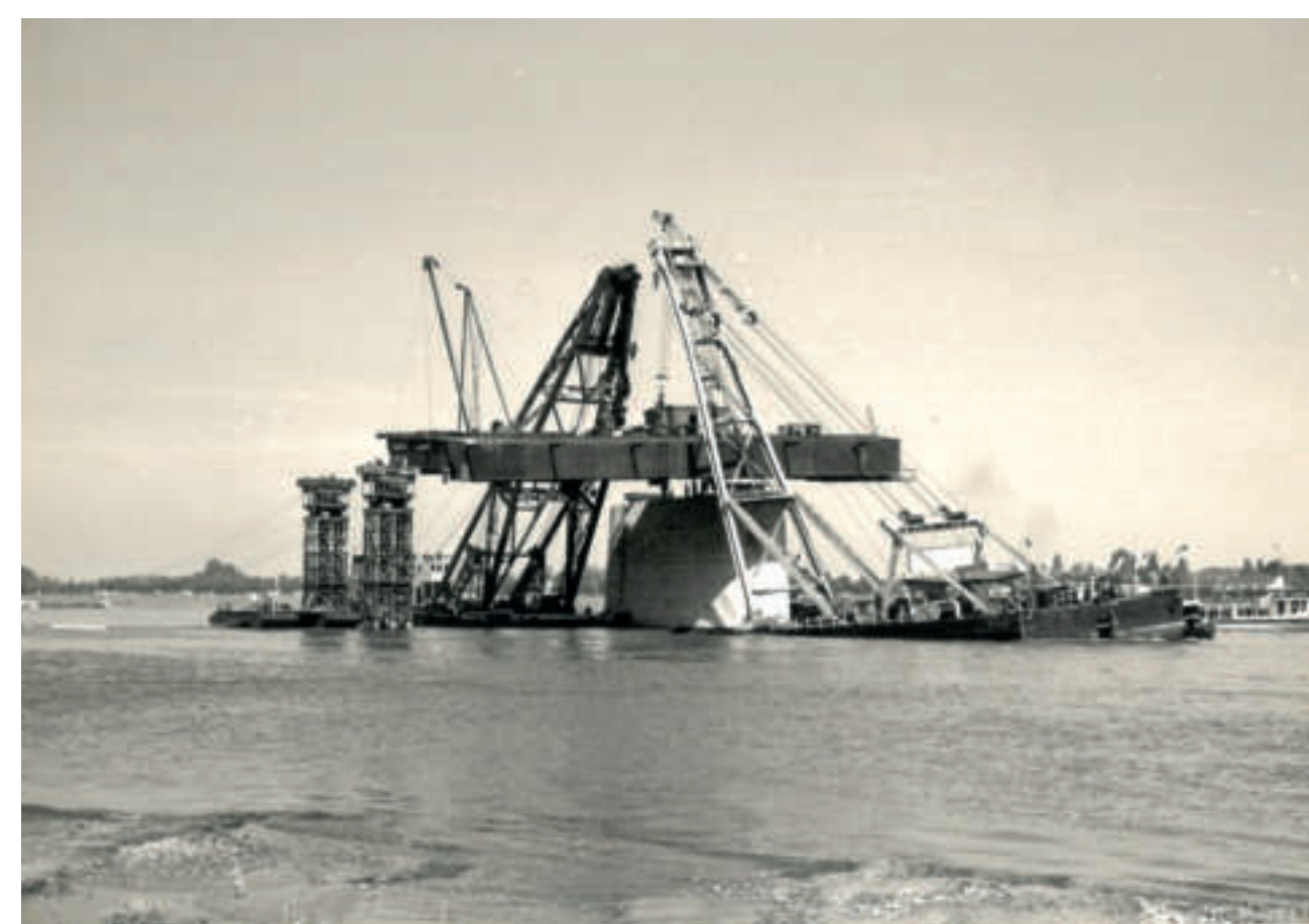
Auflegen des Teilsegments auf den Strompfeiler und die Hilfsstützen
