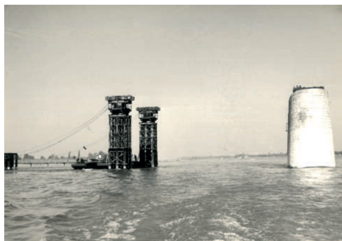
Strompfeiler mit Hilfsstützen
