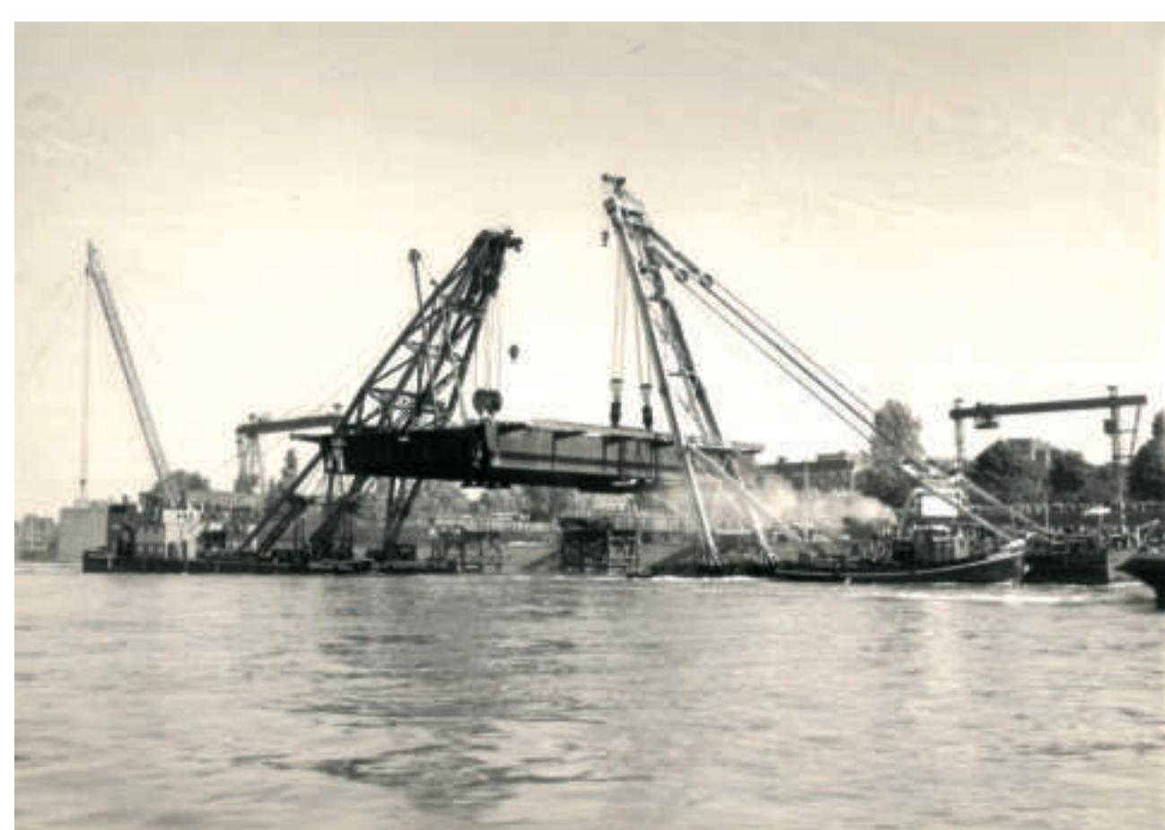
Aufnahme eines Teilsegments des Überbaus mit Schwimmkränen
