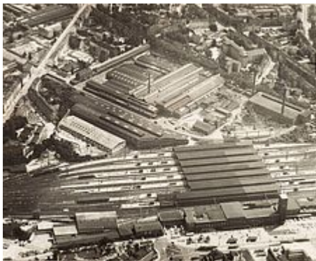
1969: Blick über die Gleisanlagen des Hauptbahnhofs auf das Oberbilkler Stahlwerk. Links die Kölner Straße. Unten Konrad-Adenauer-Platz und
