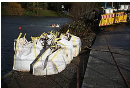
Tonnenschwere "Big Bags" werden an der Landskrone zum Bau eines provisorischen Dammes benutzt. In dessen Schutz wird eine neue Brücke errichtet, die die zukünftig offen gelegte Düssel überspannen wird.,
