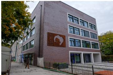
Der viergeschossige Neubau mit rund 2.400 Quadratmetern Bruttogeschossfläche wurde in Massivbauweise errichtet und verfügt über ein Biodiversitätsdach und eine zusätzliche Photovoltaik-Anlage,
