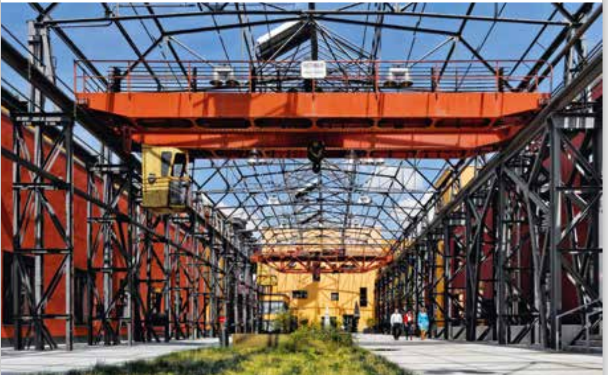
Commercial and industrial park Rheinhöfe in Düsseldorf-Holthausen. Gewerbeflächen Rheinhöfe in Düsseldorf-Holthausen.
