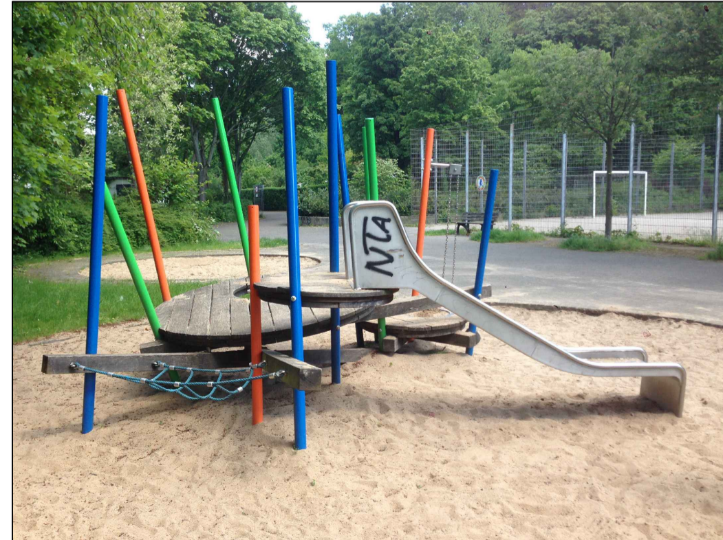
Rückbau Fritz-von-Wille Straße Versetzen des Spielgerätes an die Gutenbergstraße
