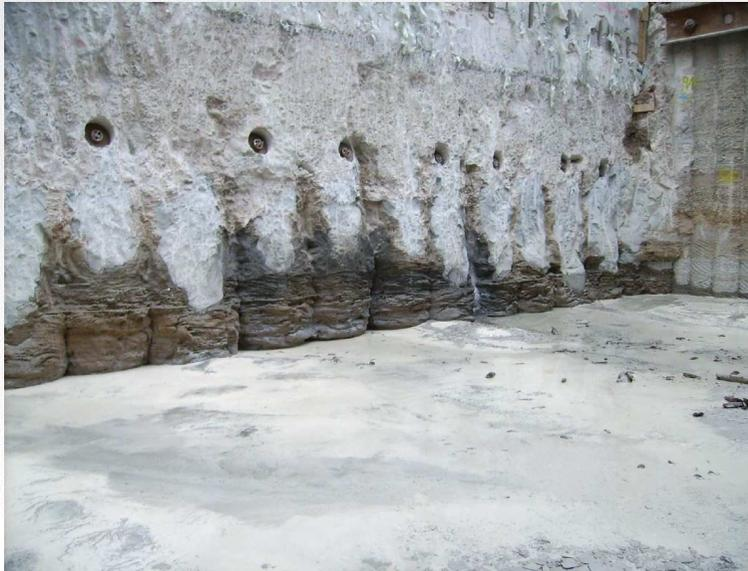
**Baugrubenwand mit Bohrpfehlen**
