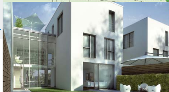
Neubaugebiet „An der Piwipp“. Dort wurden geothermische und Solaranlagen zu Heiz- und Kühlzwecken festgesetzt und realisiert.
