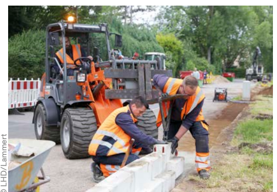
Arbeiten entlang der Nördlichen Düssel, 2022
