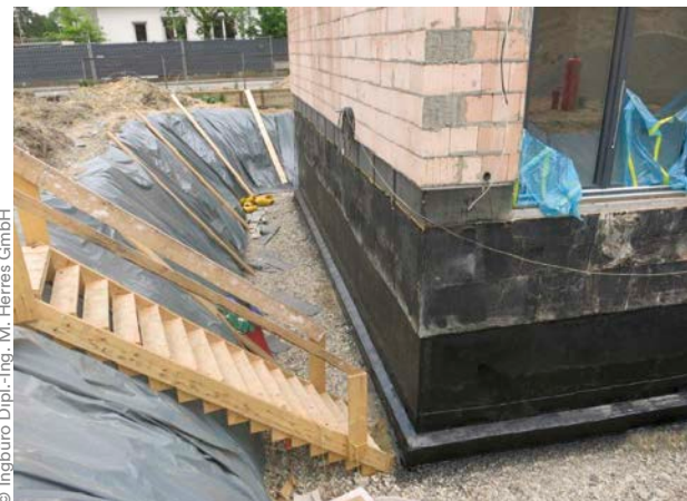
Anbringen einer Schwarzen Wanne als Grundwasserschutz
