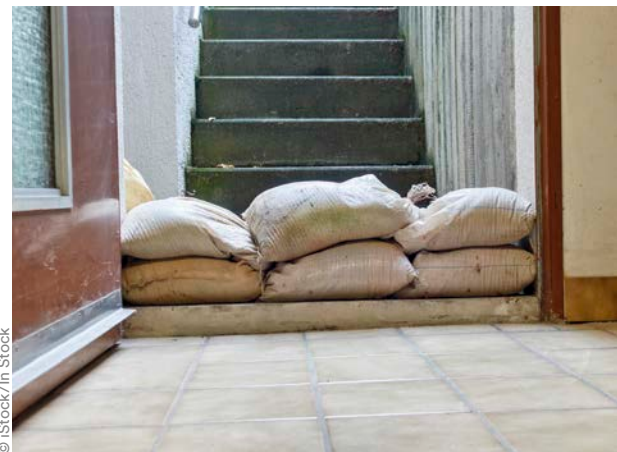
Ausgebrachte Sandsäcke zum Schutz eines Kellereingangs
