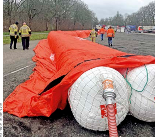
Ein zu Übungszwecken ausgelegter Schlauchdeich und ein Dammbalkenverschluss am Alten Hafen
