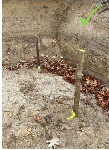
Abbildungen 9 und 10 Beispiele korrekte Markierungen mit Holzpflock
