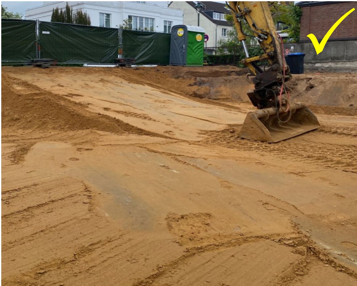
Abbildung 4 Begradigte Fläche mit Sand, ohne Höhenunterschiede größer 10cm
