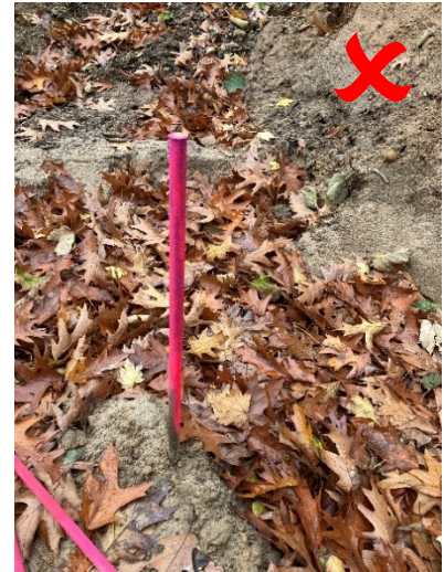
Abbildung 11 Beispiel falsche Markierung mit Metallstange
