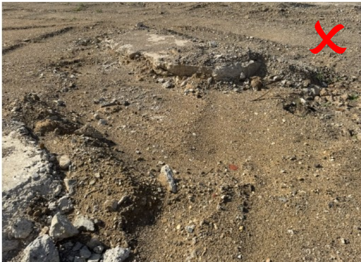
Abbildung 6 Beispiel für Störkörper (Fundamentreste, Bauschutt)
