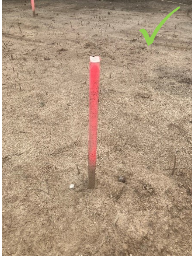
Abbildungen 9 und 10 Beispiele korrekte Markierungen mit Holzpflock
