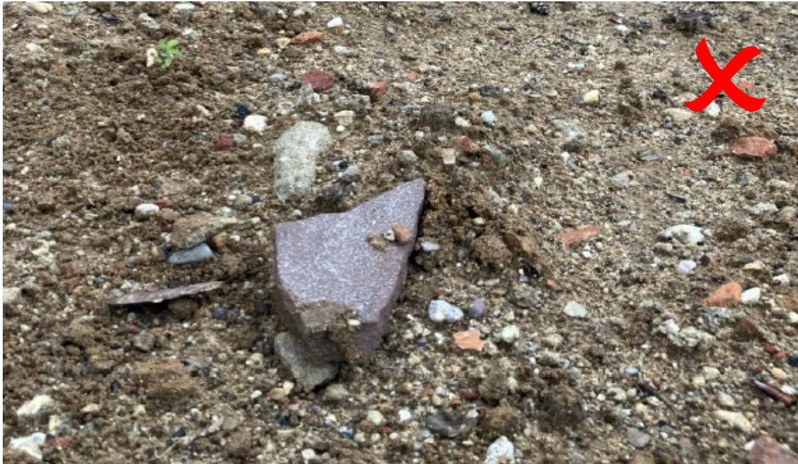
Abbildung 5 Beispiel für Störkörper (Bauschutt und Ziegelbruch)
