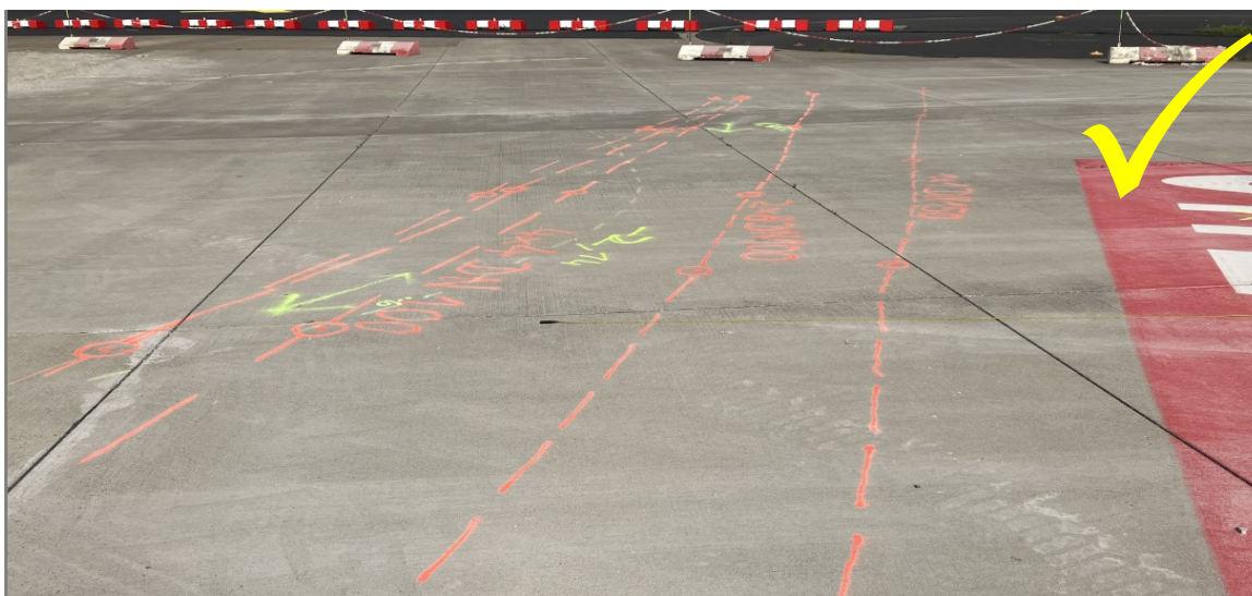
Abbildung 2 Markierung vorhandener Leitungen auf versiegelter Fläche
