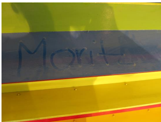
Empoussièrément au niveau des lamelles de contreplaqué
