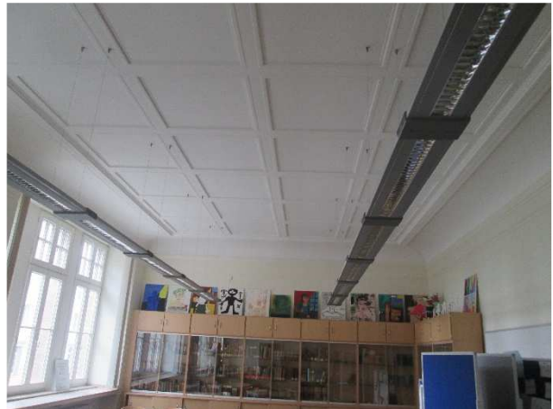
historische Deckengestaltung in einem Klassenraum
