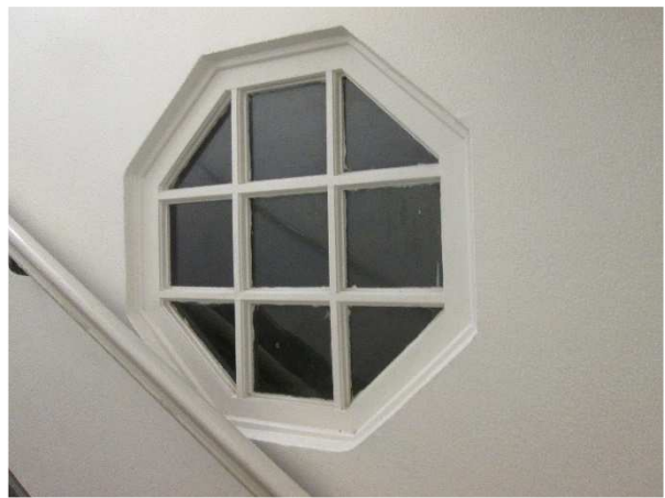
Bauzeitliches Treppenhausfenster, innenliegend
