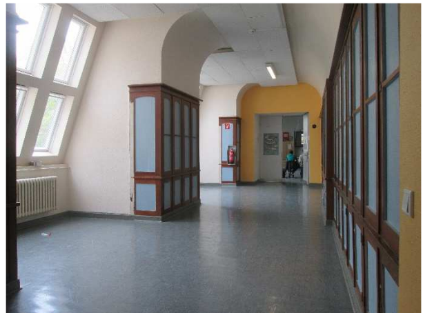
Einbauschränke im 3. OG
