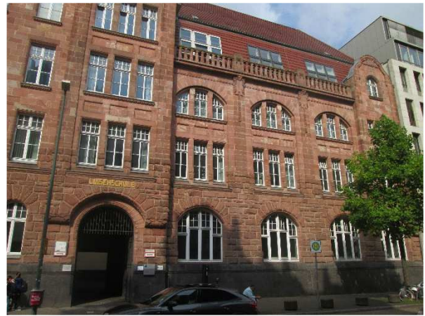
Ansicht Bastionstraße mit Tordurchfahrt
