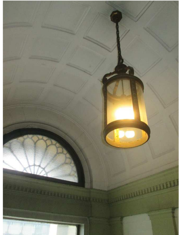
Detail Eingang Kasernenstraße 30
