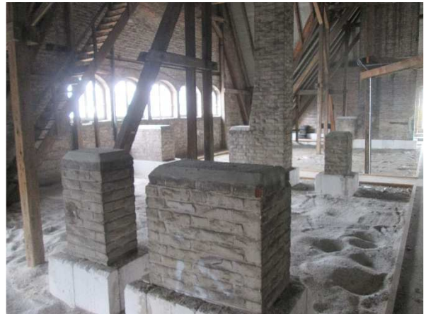
Dachraum, Blick zum Giebel der Kasernenstraße
