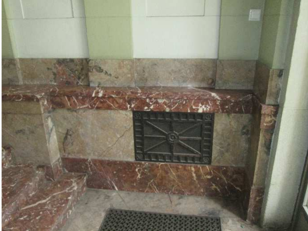
Detail Eingang Kasernenstraße 30
