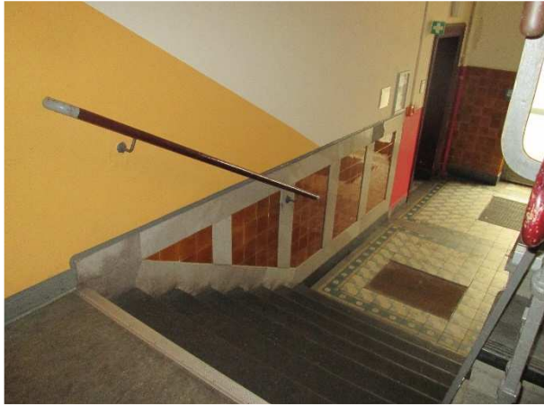
Bastionstraße 24, hofseitiges Treppenhaus mit bauzeitlichen Wand- und Bodenfliesen
