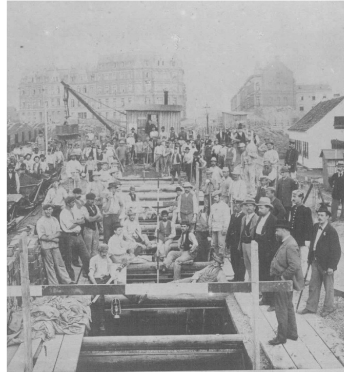
Bau des Mauerkanals in der Gerresheimerstrasse. 1898/99.
