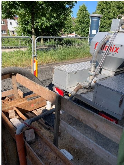
Verfüllen des Ringraums
