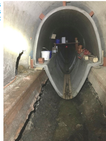
Fertig verlegtes und verkeiltes Rohr-Element
