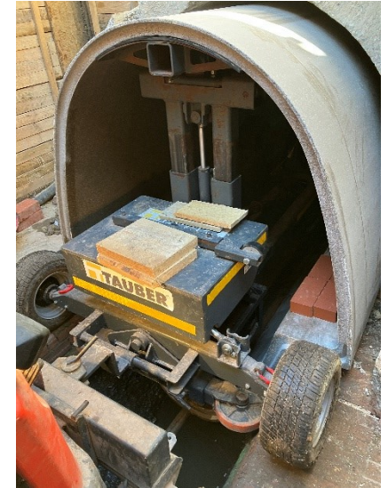
Einfahren der Elemente mit dem Transportwagen
