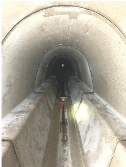
Fertig verlegte Polymerbeton-Elemente
