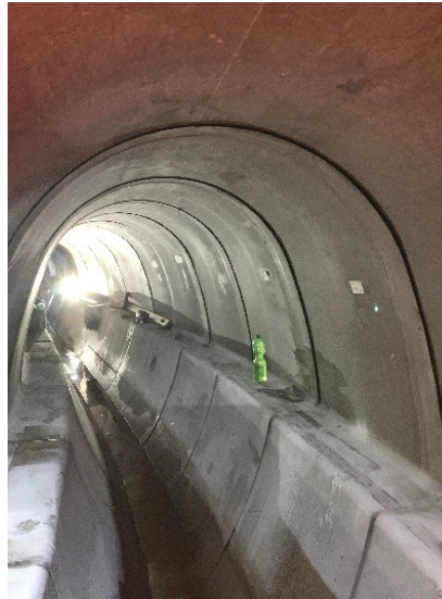
Fertig verlegte Polymerbeton-Elemente
