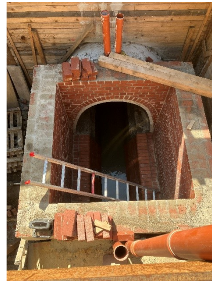
Erstellung eines gemauerten Schachtunterteils
