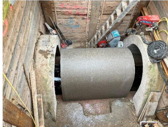
Einfahren der Elemente mit dem Transportwagen
