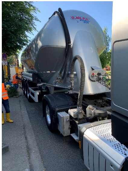
Verfüllen des Ringraums
