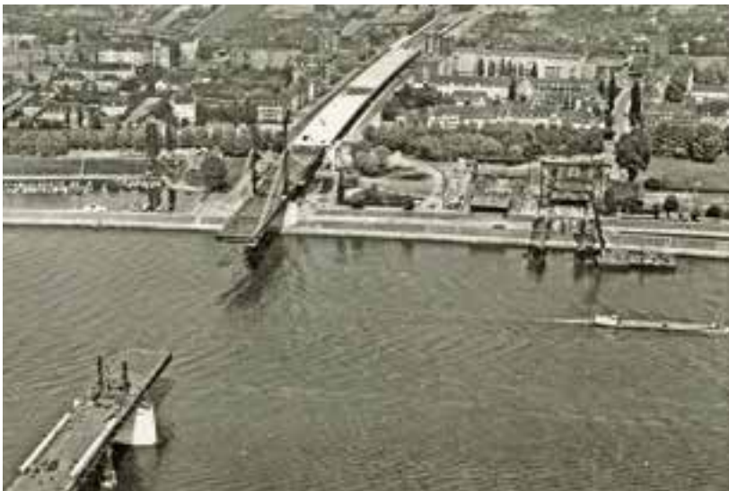
Theodor-Heuss-Brücke im Bau 1955
