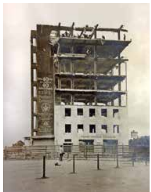
Abriss des Feuerwehrturms 1927
