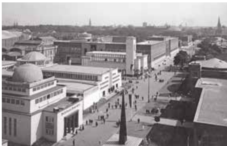
Ausstellungshallen GeSoLei mit Ehrenhof und Rheinterrasse (vorne rechts), 1926
