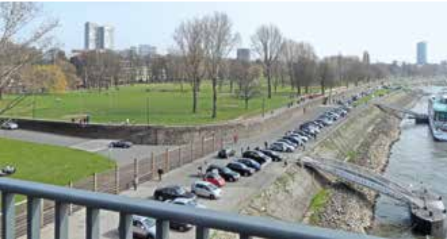
Robert-Lehr-Ufer mit Hochwasserschutz, 2011
